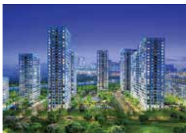
Vinhomes Central Park Loại thang sử dụng: Schindler 5400 Số lượng: 4 Tốc độ: 1.75 m/s, 2.25 m/s Số điểm dừng: 15, 27 Trọng tải: 900, 1600 Kg
