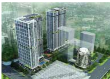
Tòa Thăng Long Loại thang sử dụng: Schindler 5400 Số lượng: 4 Tốc độ: 1.75 m/s, 2.25 m/s Số điểm dừng: 15, 27 Trọng tải: 900, 1600 Kg
