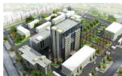
Bệnh viện đa khoa Thái Nguyên Loại thang sử dụng: Mitsubishi Số lượng: 5 Tốc độ: 1.75 m/s Số điểm dừng: 15 Trọng tải: 750, 1600 Kg
